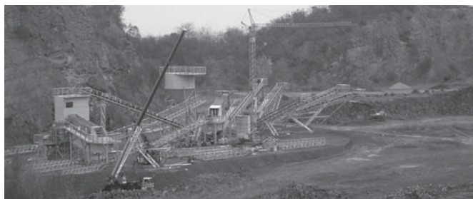
1. ábra A dunabogdányi technológiai sor építése
